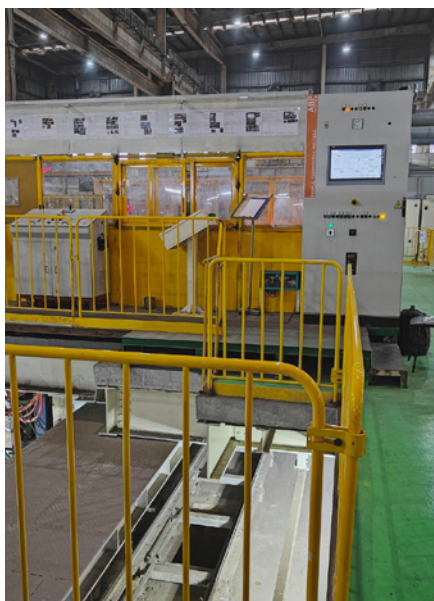
Alle Öfen und Anlagen wurden fristgerecht installiert.
